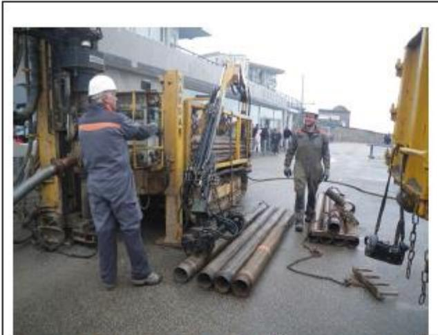
*Forage et alimentation en tube à l'avancement et en barre de forage*
