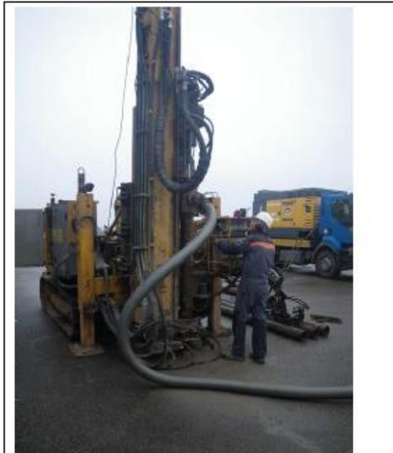
*Le pré-tubage est amené jusqu'au toit rocheux et l'ancrage déterminé par calcul est réalisé.*
