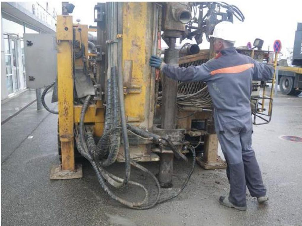
*Mise en position stable de la machine, on vient coiffer la tête du tube et la tige de forage, la tige de forage est vissé à la tête de rotation et le système de récupération des cuttings est vissé sur la tête du tube.*
