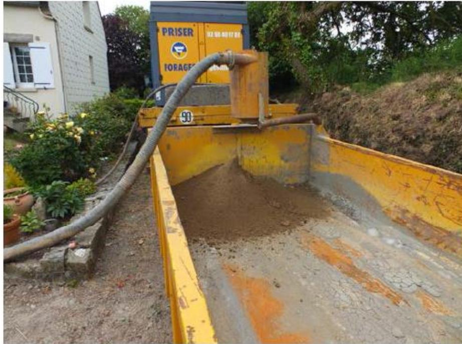
*Les cuttings sont évacués au fur et à mesure du forage dans une benne et envoyés dans une décharge de classe III.*
